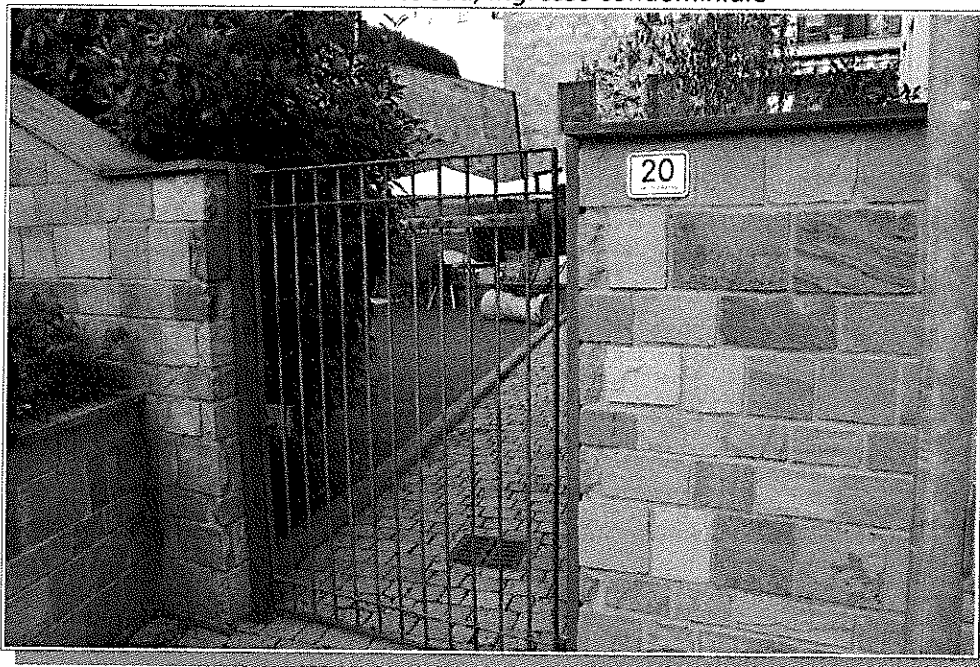
Foto 2 – Fronte sud, ingresso condominiale
